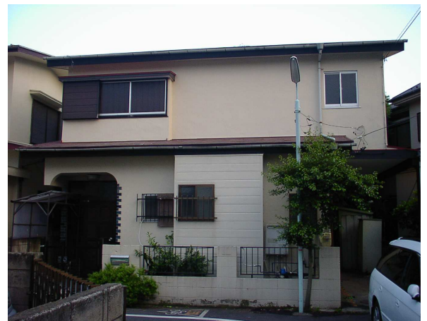
リフォーム前：車庫屋根上に2階増築(耐震性低下)
