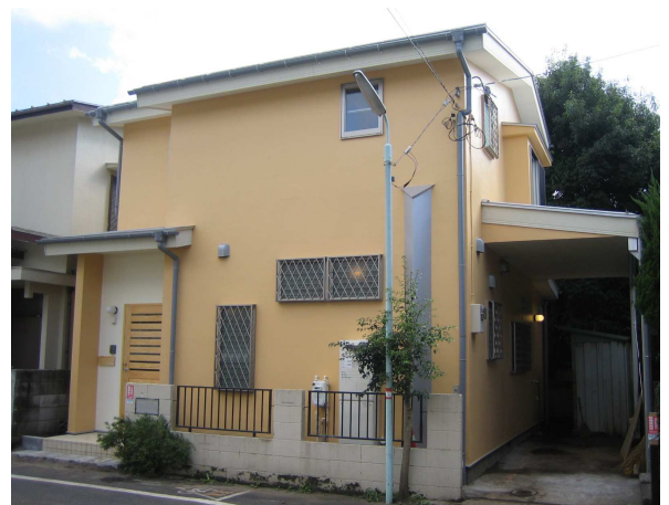
リフォーム後：2階増築部と洗面所を撤去(耐震補強)
