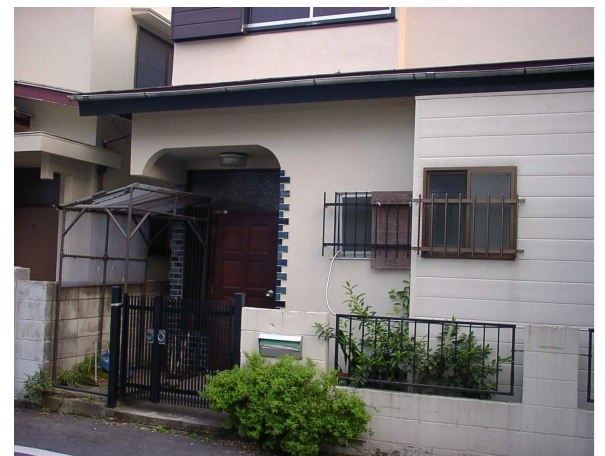
リフォーム前：北側に洗面所を増築(耐震性低下)
