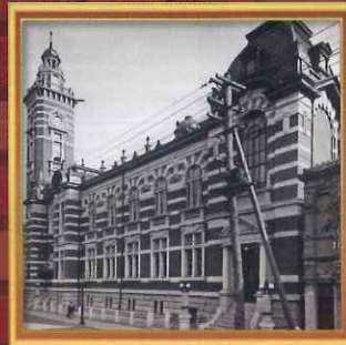
大正6年竣工時の会館
