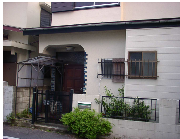
リフォーム前：北側に洗面所を増築（耐震性低下）
