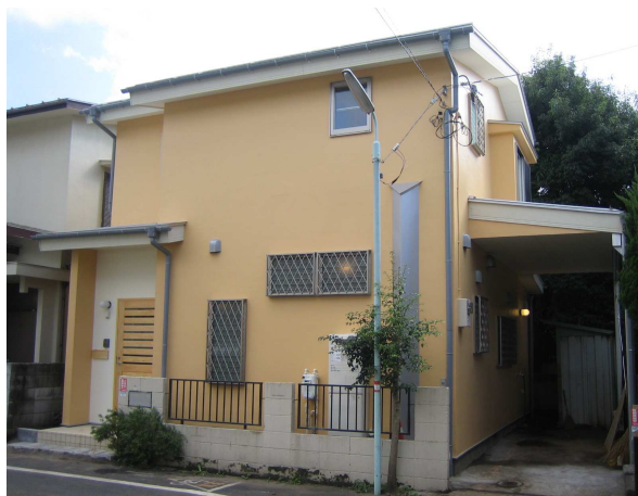
リフォーム後：2階増築部と洗面所を撤去（耐震補強）
