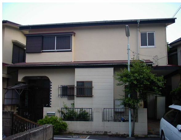
リフォーム前：車庫屋根上に2階増築（耐震性低下）
